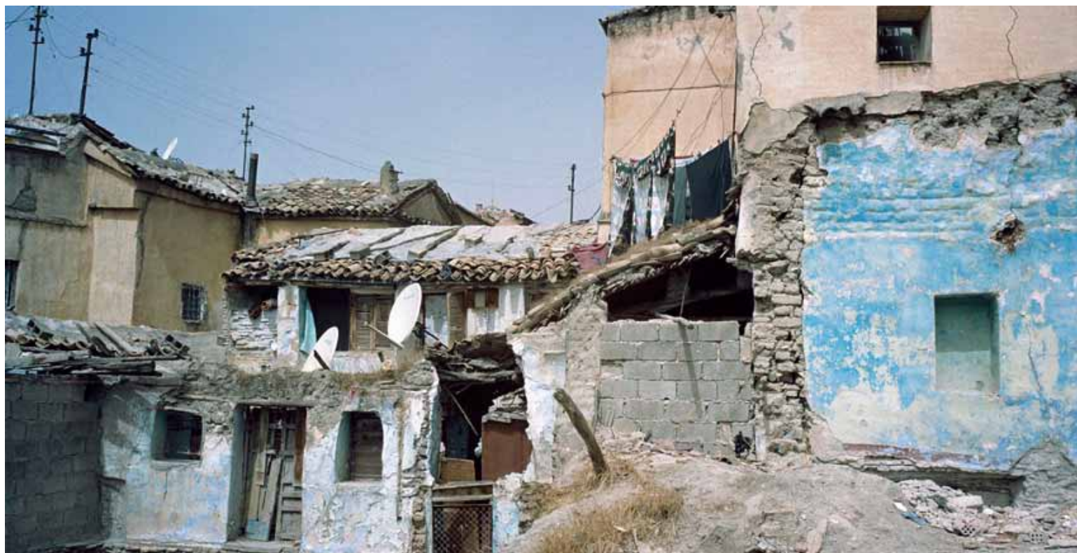
Le silence des ruines , installation bâchée Série Souika 2, 212 x 414 cm
